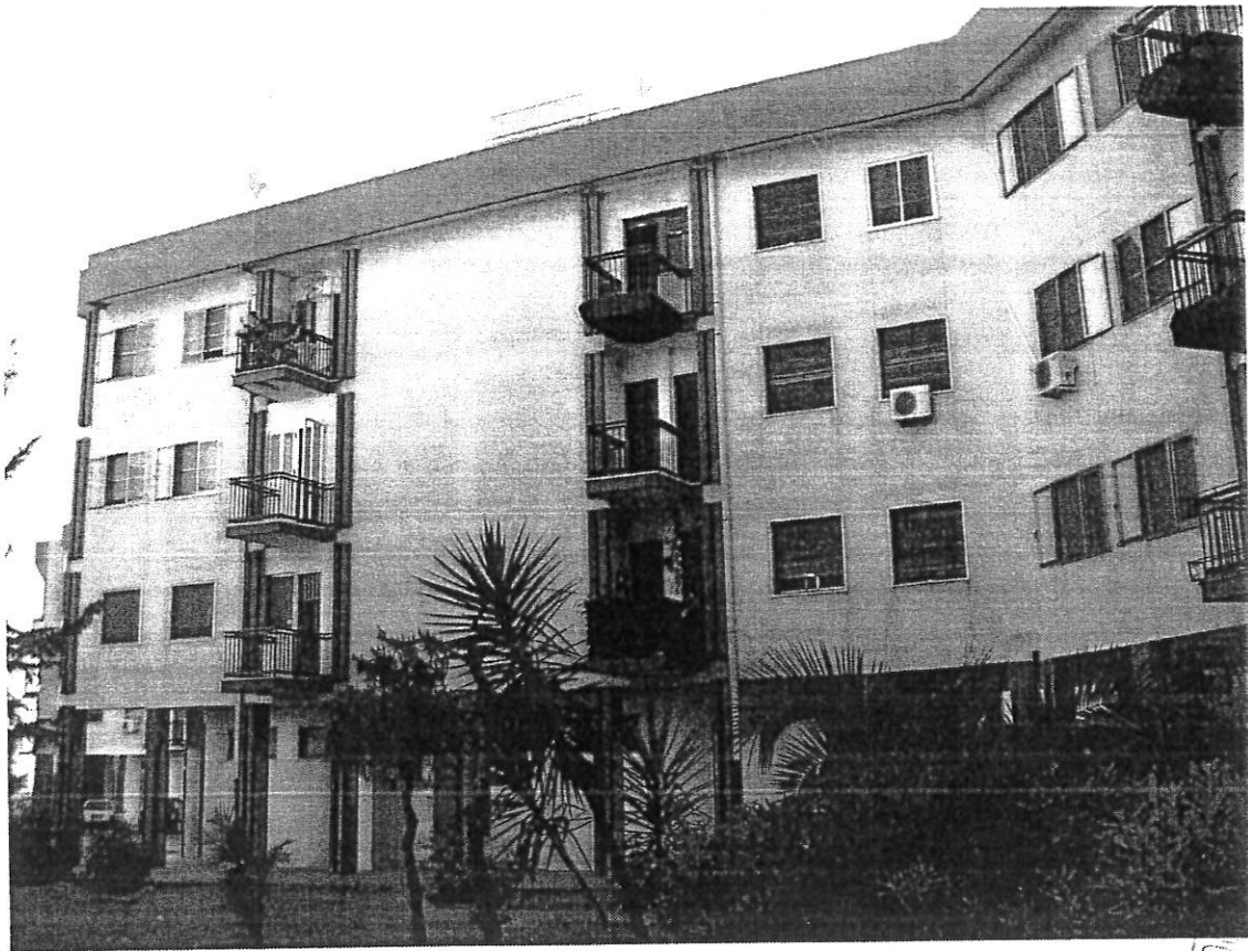
1 Prospetto verso il piazzale
